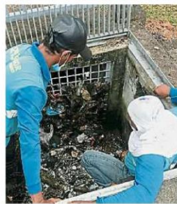
排水口垃圾堆积致排水受阻。
