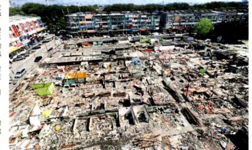
■旧巴刹建筑结构已经拆除，避免非法商販进驻，非法营业。
